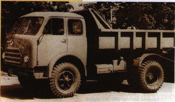
**Строительный «МАЗ-503Б» оборудовался подогревом днища кузова в зимнее время выхлопными газами. Это вариант 1963 года. Фото из архива А.С. Исаева**
