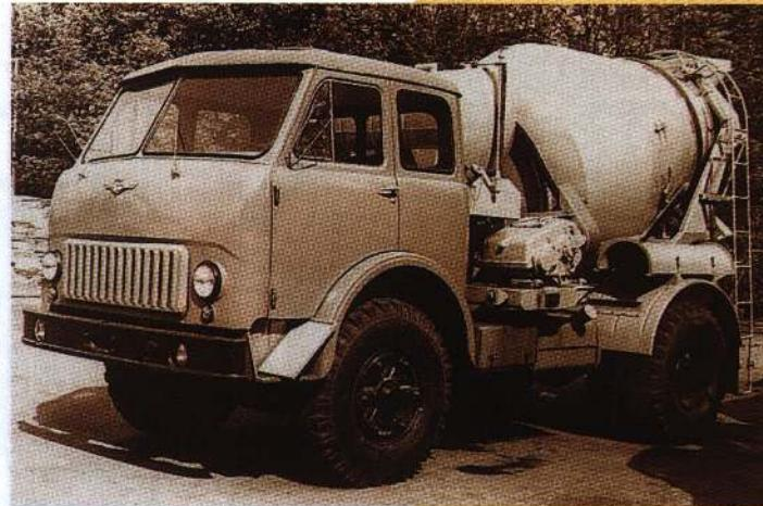
Автобетоносмеситель «С-1036» на шасси «МАЗ-504» предназначался для приготовления и транспортировки бетонной смеси. Такие бетономешалки выпускал «Славянский завод строительных машин» с 1970 года. Фото автора
