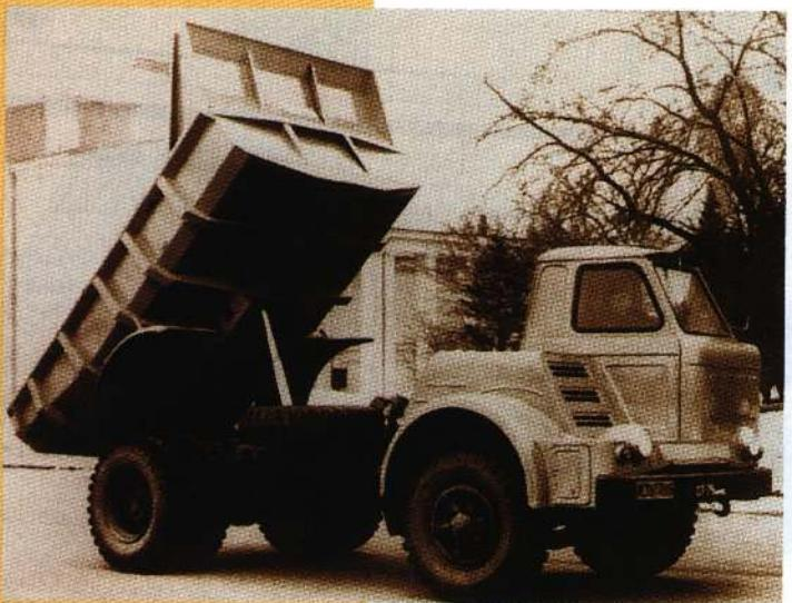
**Опытный образец карьерного автосамосвала «МАЗ-510» отличался одноместной кабиной, так как погрузочные и разгрузочные работы в карьерах были механизированы и не требовалось возить с собой грузчиков. Он был построен в 1962 году. Фото из архива А.С. Исаева**
